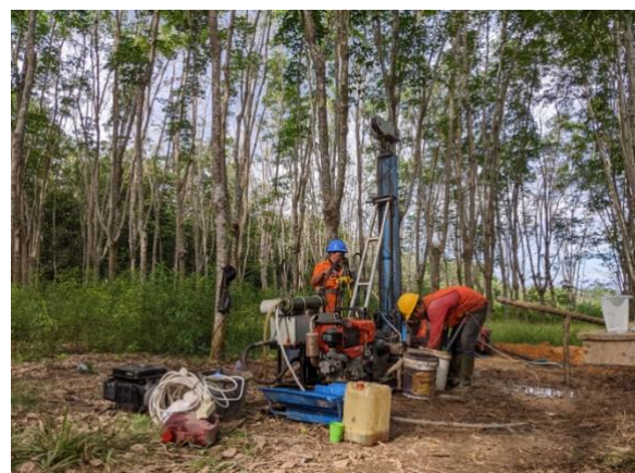
Proses pengeboran pada lokasi APE
