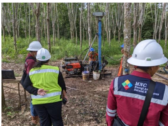
Proses pengeboran pada lokasi APE (Arthaco Prima Energi)
